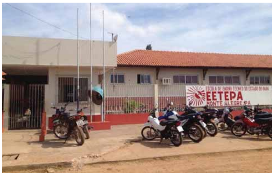
Figura 62: Vista da fachada da EETEPA. Fonte: Instituto Avaliação (2017).
