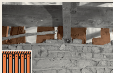
FIGURA 28 - Tábuas pregadas NA ESTRUTURA PRINCIPAL
