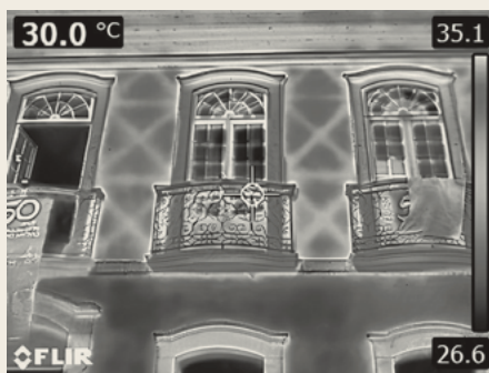
FIGURA 32 – Exemplo de ensaio não destrutivo - termografia da fachada de edificação situada na rua Getúlio Vargas, nº185, bairro Rosário - Ouro Preto. Fonte: A Pique Arquitetura, 2025.
