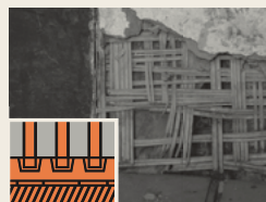
FIGURA 24 ENCAIXADO em peça auxiliar sobre o piso tabuado
