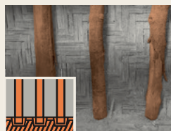
FIGURA 23 ENCAIXADO na estrutura principal
