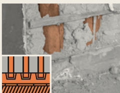
FIGURA 17 - ENCAIXADO em peça auxiliar sobre o piso tabuado
