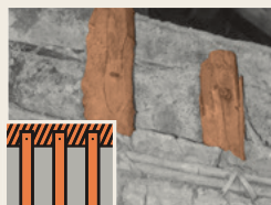
FIGURA 14 - PREGADO na estrutura principal
