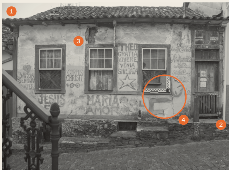
FIGURA 30 – Fachada de edificação na Rua Barão de Ouro Brando, nº92 - Bairro Soares. Fonte: Adelaide Dias, 2025.
