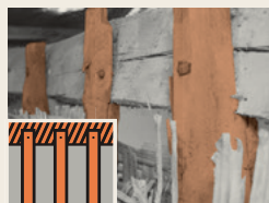
FIGURA 22 PREGADO na estrutura principal
