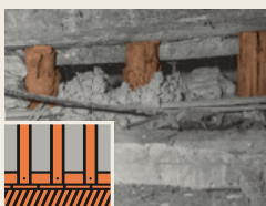
FIGURA 15 - PREGADO em peça auxiliar
